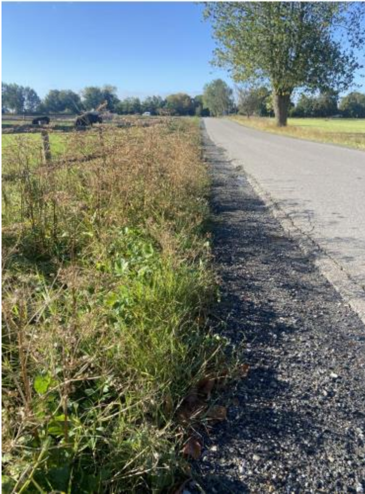
Foto: Kabelnedgravning på Hastrupvej
